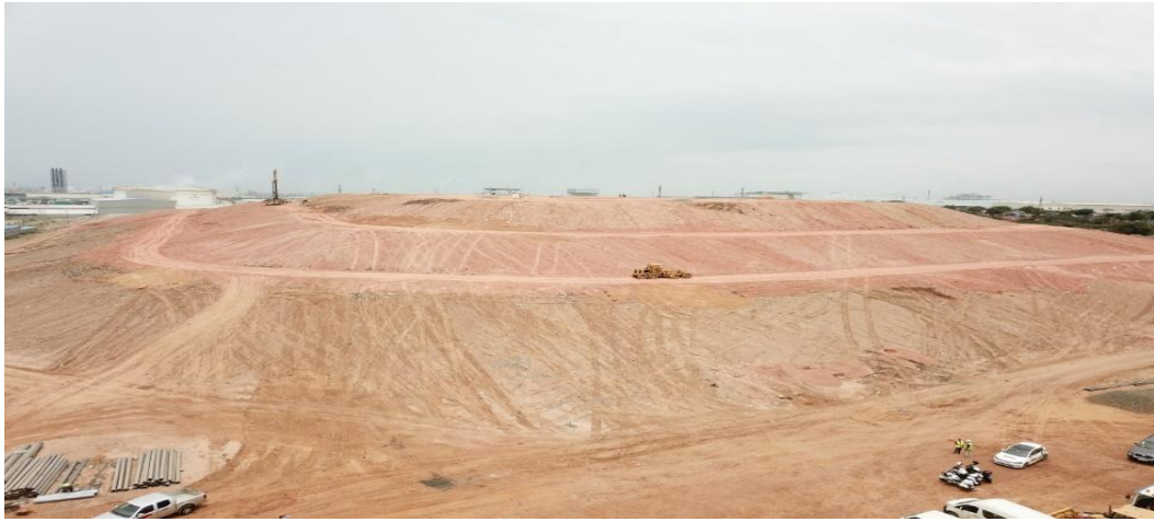
Appendix 6 (d) Final Stages of Decommissioning of Kokompe Landfill Source: EAP Consult, 2023
