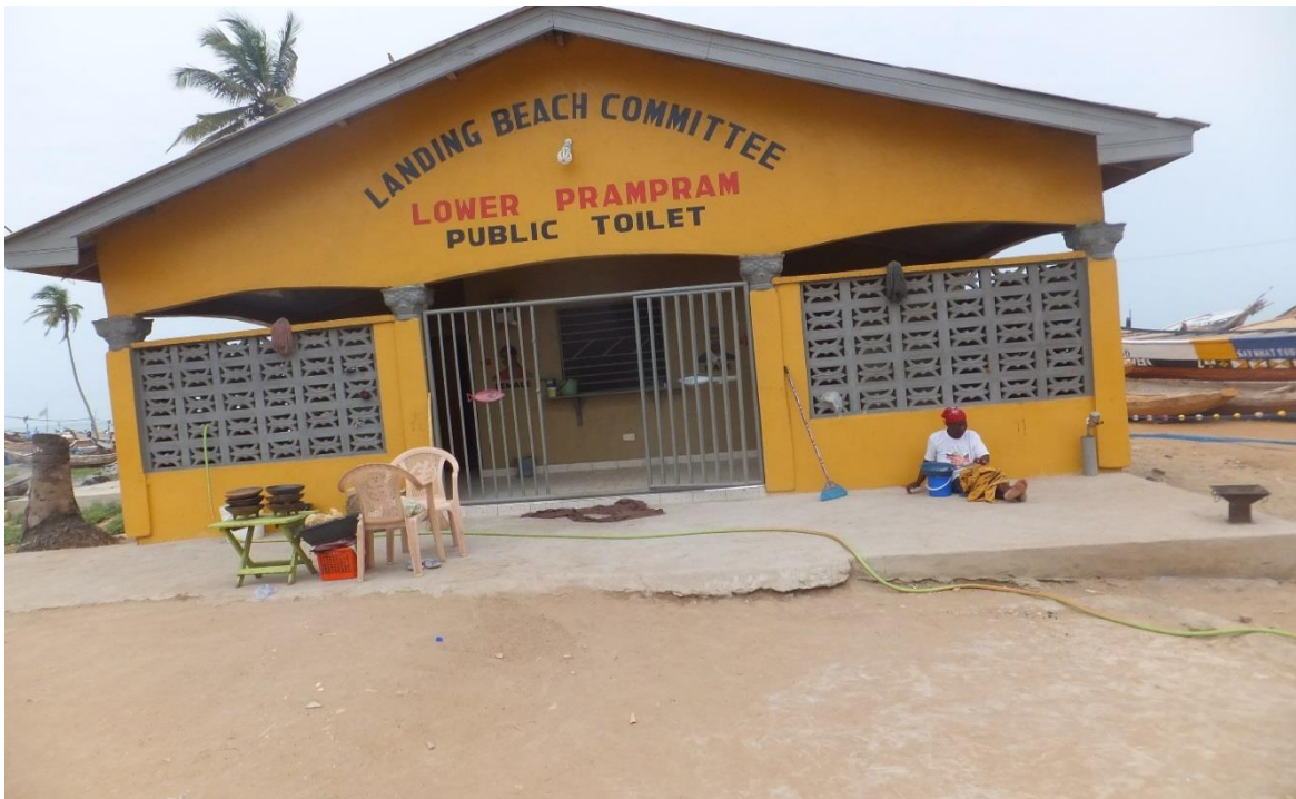
Figure 6.11: New Public Toilet – Pour Flush
