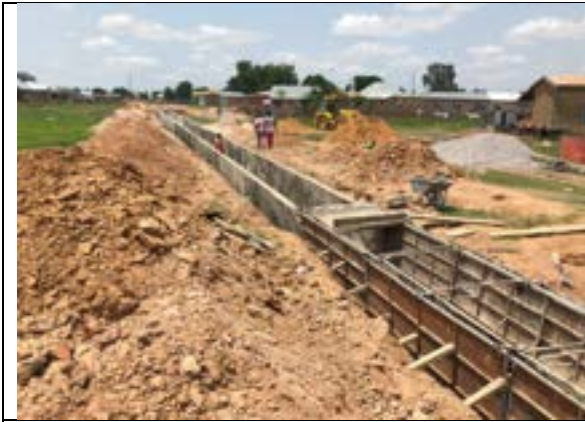
Figure 5.4 Drain Construction (Kalariga)
