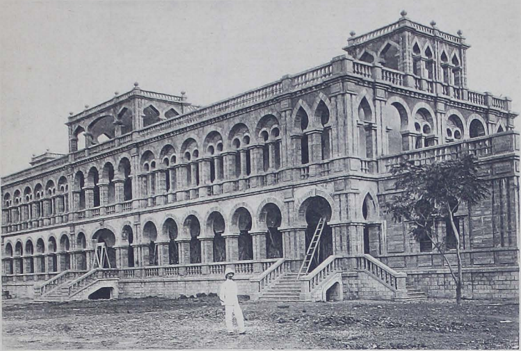
FIG. 5. — Koulouba, le palais du Gouverneur (pendant la construction).
